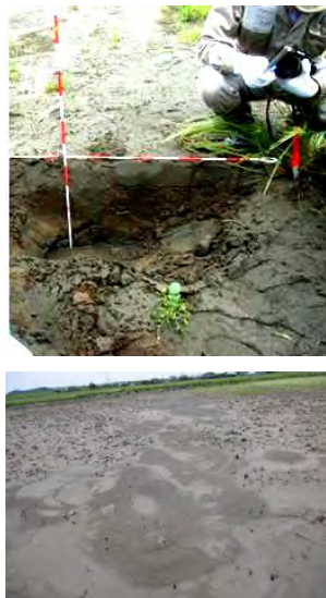
Fig. 2 液状化によって 砂が噴出した農地 (up) 噴砂口の断面の様子 (down) 噴砂口と その周辺の様子
